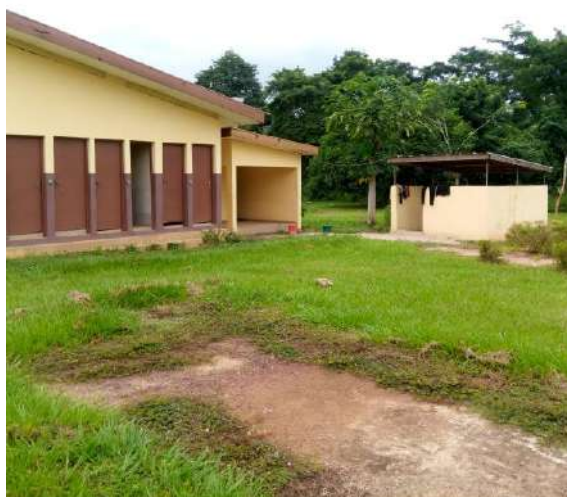
Vue générale de bâtiments servant de toilettes
