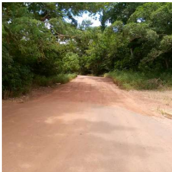
Figure 4: Piste reliant l'ESA à sa ferme école/Voie d'accès
